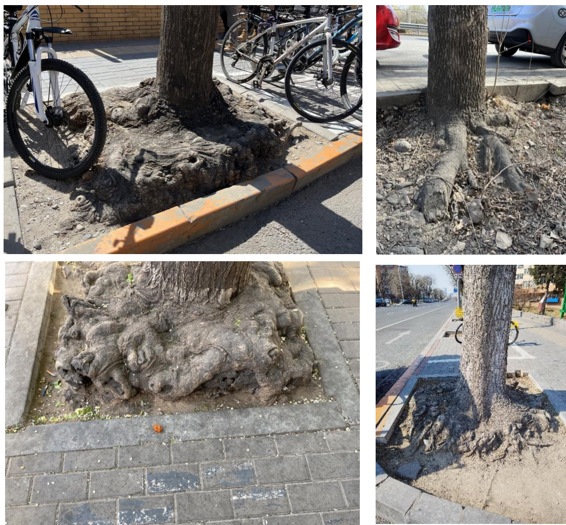
图10 施工切根示例
